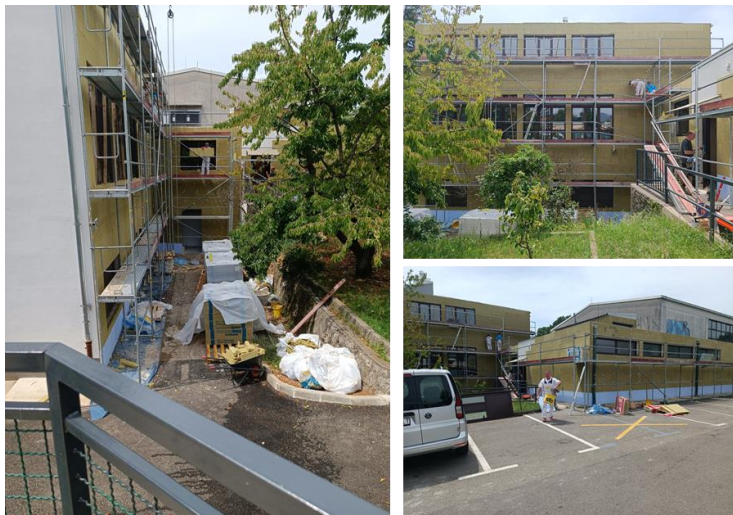
srpanj 2023. – nastavak radova na obnovi fasade
