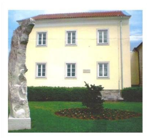
Zgrada PŠ Grobnik u Gradu Grobniku
