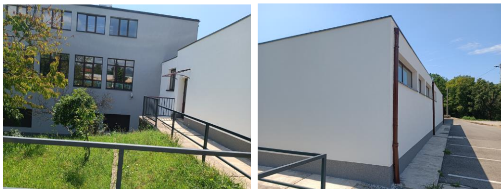
Završetak radova na fasadi matične zgrade škole, srpanj 2023. – III. faza
